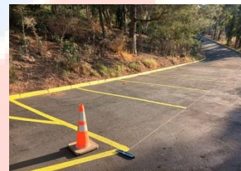
Recuperación suelo estacionamiento
