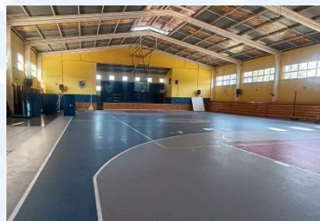
Recuperación piso gimnasio
