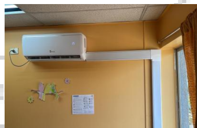
Instalación de aires acondicionados
