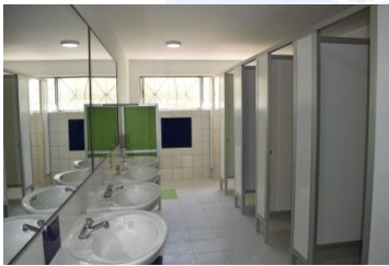
Remodelación de baños pre - básica
